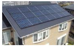
太陽光パネル
