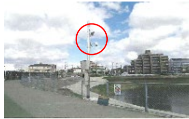
監視カメラの設置
