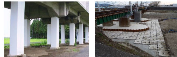
鋼板巻きによる高架橋の耐震補強 鉄道橋りょうの流失・傾斜対策
