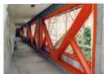
鉄骨ブレースによる壁の補強
