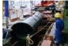
基幹管路の耐震化
