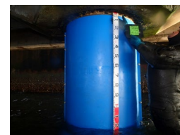
鋼管杭の被覆防食の更新
