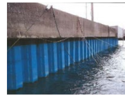
岸壁、鋼製矢板の腐食対策
