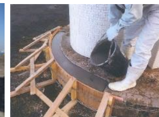
▲亀裂補修(環境遮断)
