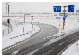
消融雪施設の整備
