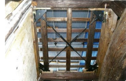
構造用合板補強（床・壁の内部）
