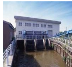
排水機場の整備
