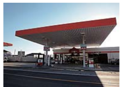
えび屋石油公衆トイレ（渋川市）
