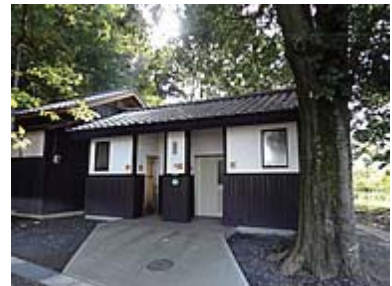
小幡八幡神社公衆トイレ（甘楽町）
