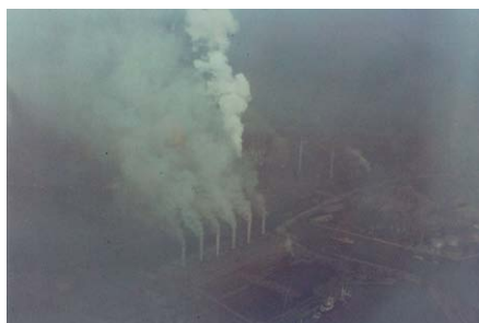
尼崎の火力発電所 1963年1月22日
