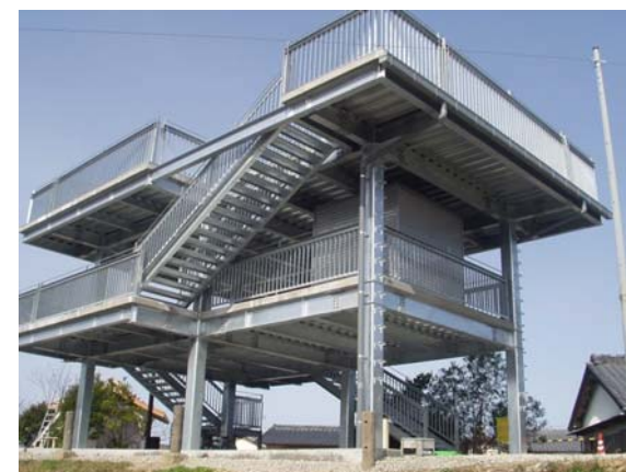
〔津波避難タワー〕
