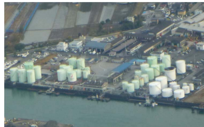
〔タナスカ地区石油・ガス基地〕
