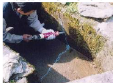
水路のひび割れ補修
