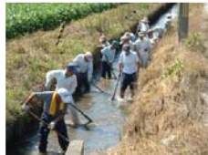
水路の泥上げ
