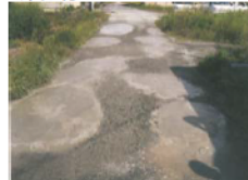
農道の窪みの補修
