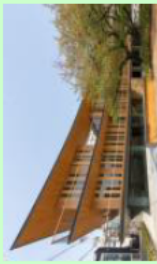
3層構成型耐火集成材を主要構造部に用いた事務所
