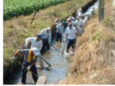
水路の泥上げ
