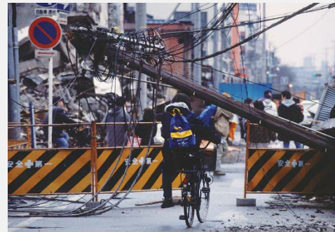
地震発生時の電柱の倒壊状況 （阪神・淡路大震災の例）
