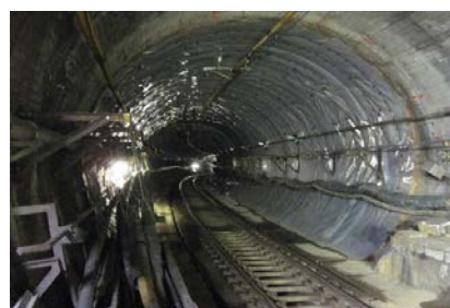
トンネル漏水対策
