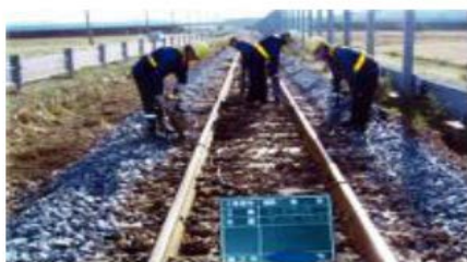
ケーブル更新（トラフ交換）
