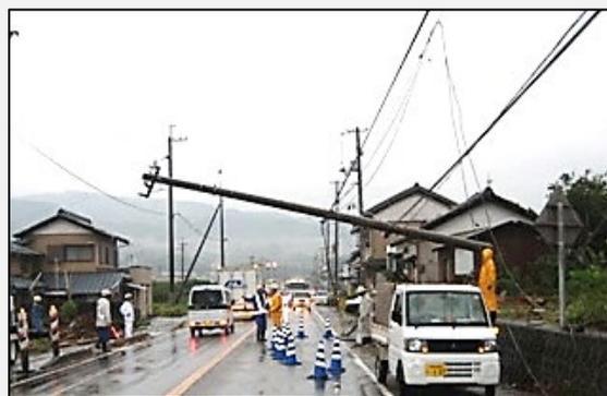
電柱が倒壊し、道路を閉塞した事例
