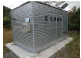
防災倉庫への取り付け事例
