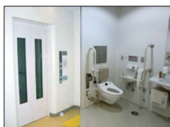
左:エレベーター、右:多目的トイレ
