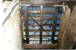
構造用合板補強（床・壁の内部）
