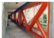
鉄骨ブレースによる壁の補強
