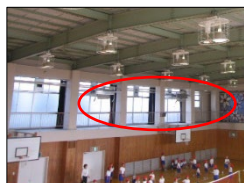
体育館への空調設置
