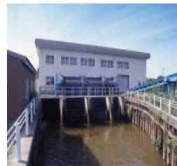
排水機場の整備
