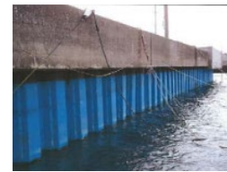
岸壁、鋼製矢板の腐食対策
