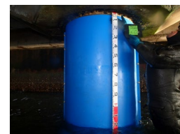
鋼管杭の被覆防食の更新
