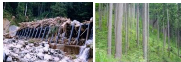
流木捕捉式治山ダムの設置
