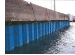
岸壁、鋼製矢板の腐食対策
