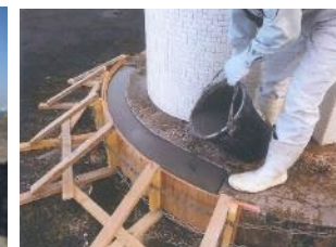
▲亀裂補修(環境遮断)
