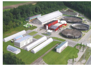
バイオガス発電・熱利用
