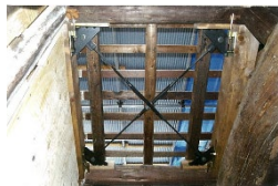
構造用合板補強（床・壁の内部）
