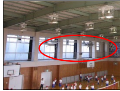
体育館への空調設置
