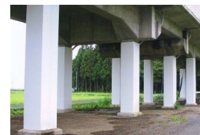
鋼板巻きによる高架橋の耐震補強
