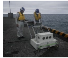
レーダー探査機による岸壁の空洞化調査
