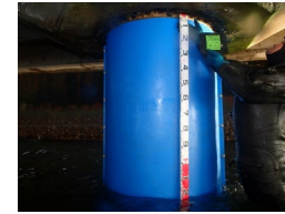
鋼管杭の被覆防食の更新
