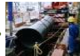
基幹管路の耐震化
