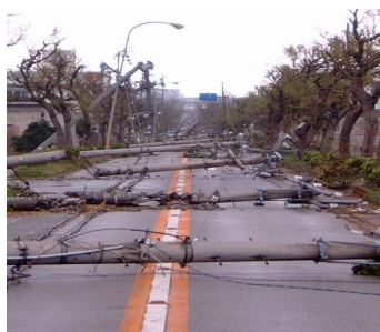
電柱の倒壊による道路閉塞
