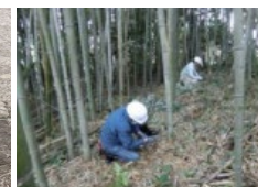
侵入竹の伐採・除去
