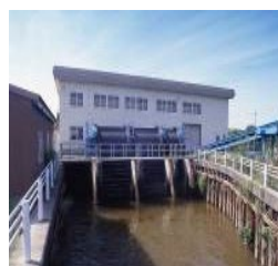
排水機場の整備
