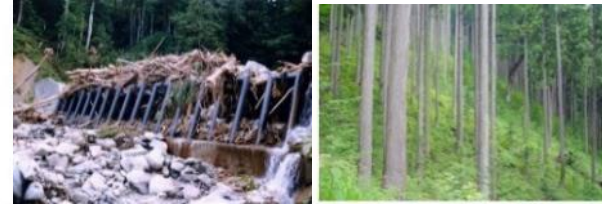
流木捕捉式治山ダムの設置
