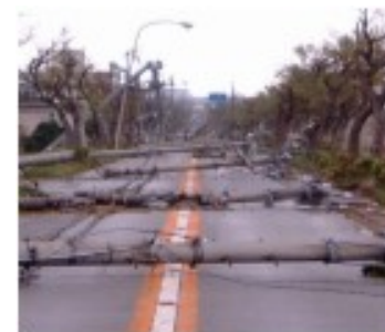
電柱の倒壊による道路閉塞
