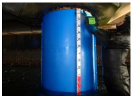
鋼管杭の被覆防食の更新
