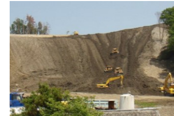
盛土撤去工事のイメージ
