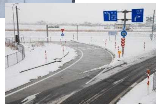
消融雪施設の整備
