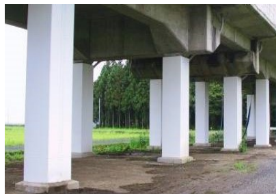
鋼板巻きによる高架橋の耐震対策
