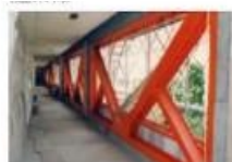
鉄骨ブレースによる壁の補強
