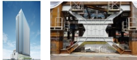
「JPタワー名古屋(左写真)」や「Aichi Sky Expo」に設置された制振ダンパー(写真右)
