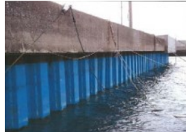
岸壁、鋼製矢板の腐食対策
