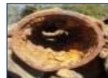
管路の老朽化が進行
