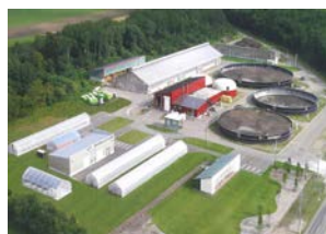
バイオガス発電・熱利用
