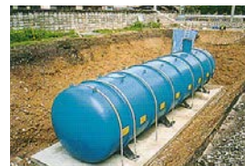
耐震性貯水槽
