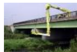
橋梁点検車を使った橋梁点検
