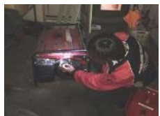
自家発電設備により、SSの電力を確保し、災害時における燃料供給に貢献
