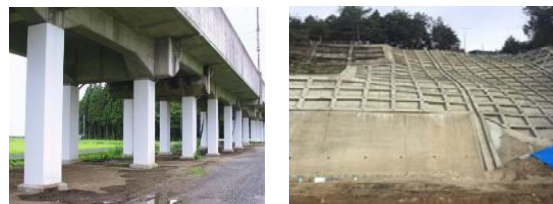
【鋼板巻きによる耐震対策】【法面防護工による土砂流入防止対策】
