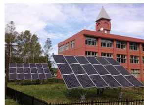
避難所に設置した太陽光発電
