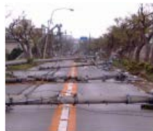
電柱の倒壊による道路閉塞
