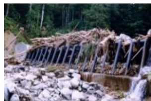
流木捕捉式治山ダムの設置
