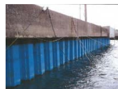
岸壁、鋼製矢板の腐食対策
