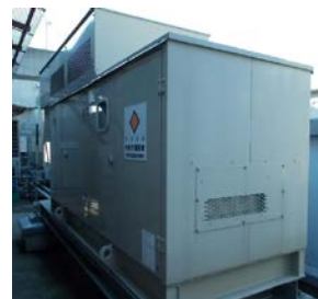
(非常用自家発電装置)
