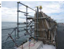
<既存護岸の嵩上げ>
