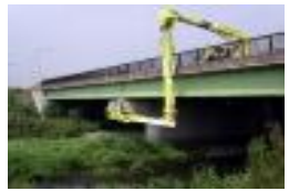
橋梁点検車を使った橋梁点検
