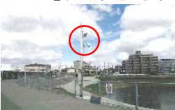
監視カメラの設置
