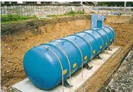
耐震性貯水槽
