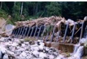
流木捕捉式治山ダムの設置
