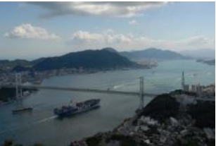
瀬戸内海の狭険部における船舶航行状況
