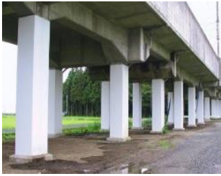
【鋼板巻きによる耐震対策】
