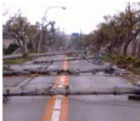
電柱の倒壊による道路閉塞
