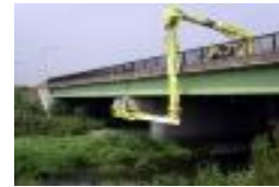
橋梁点検車を使った橋梁点検
