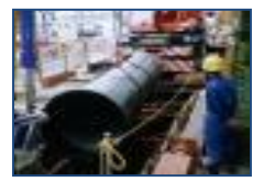
基幹管路の耐震化
