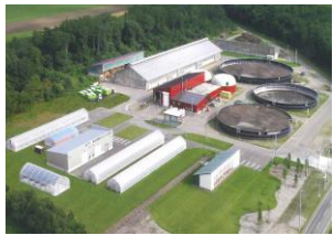
バイオガス発電・熱利用
