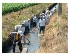
水路の泥上げ
