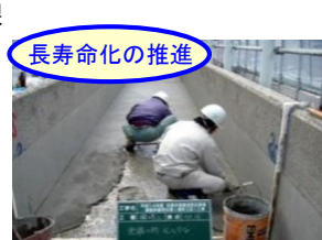
開水路の補修
