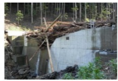
治山ダムによる流木の流出等の抑制
