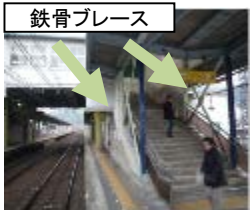
橋上駅の補強
