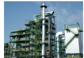
木質バイオマス発電所
