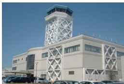
管制塔等の倒壊防止
