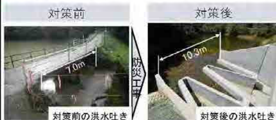
対策前の洪水吐き 対策後の洪水吐き
