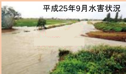
整備前の写真
