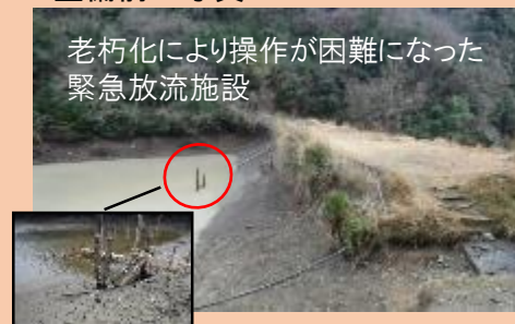
整備前の写真
