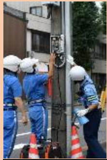
災害に備えた交通安全 施設等の点検・整備
