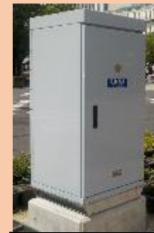
信号機電源付加装置 (自動起動式)
