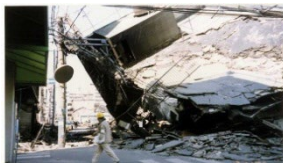
倒壊し道路を塞ぐ建築物
