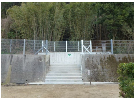
急傾斜地崩壊防止対策施設を活用した津波避難階段
