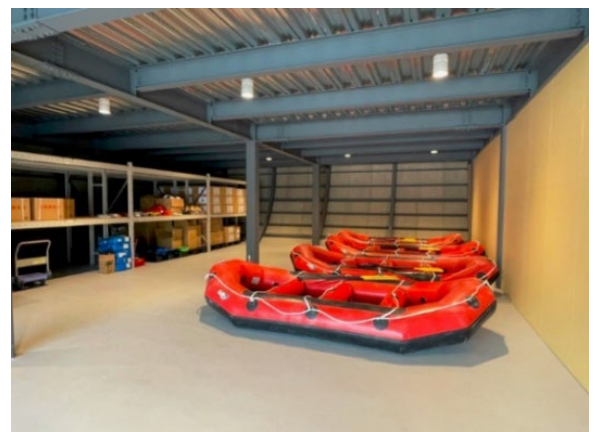
防災倉庫内部写真
