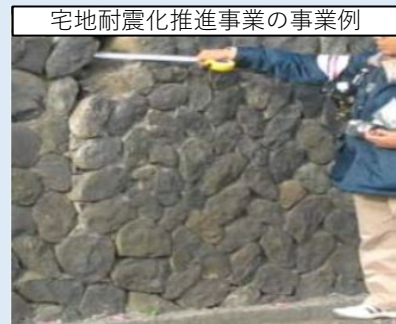
↑ 擁壁の危険度調査
