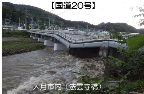
橋脚沈下による交通の寸断
