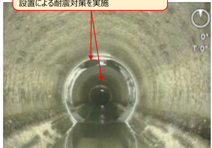
幹線管渠の耐震対策状況
