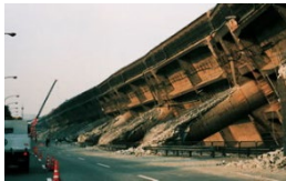
倒壊した阪神高速道路
