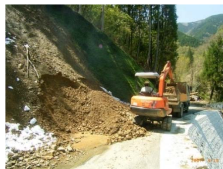
【土砂崩れ現場での作業】
