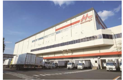
【森永乳業 東京多摩工場】
