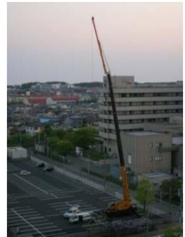
【クレーン車での空中線設置】
