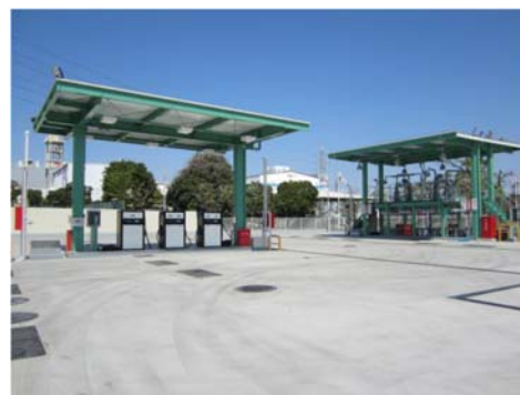
【杉戸燃料備蓄基地の外観】
