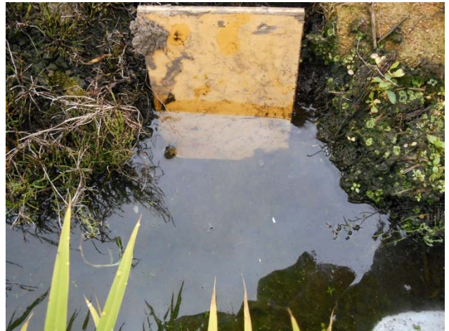
【止水板による止水状況】
