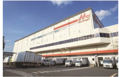
【森永乳業 東京多摩工場】
