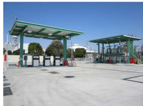
【杉戸燃料備蓄基地の外観】
