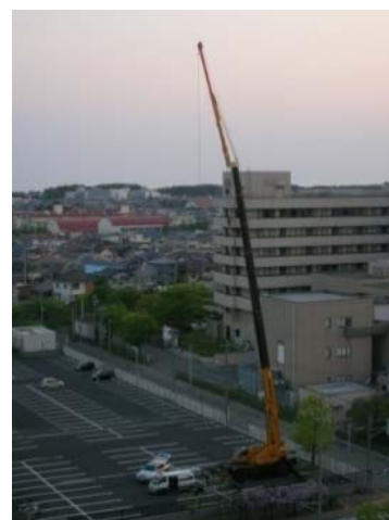
【クレーン車での空中線設置】
