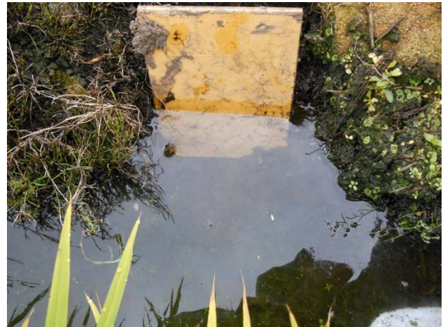
【止水板による止水状況】
