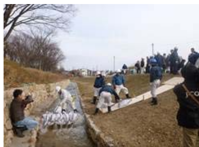
【水路を利用した訓練の様子】
