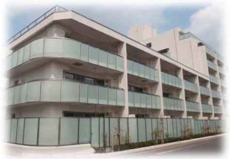
【耐震補強工事施工後】
