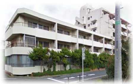
【耐震補強工事施工前】
