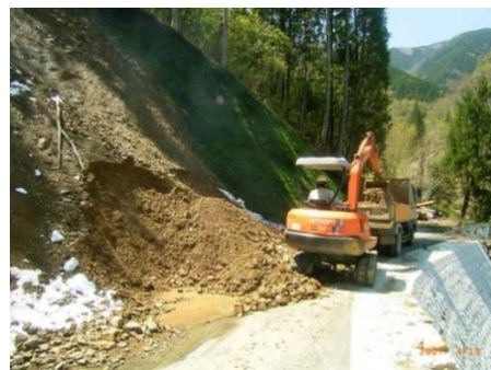
【土砂崩れ現場での作業】
