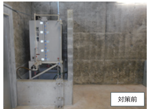
予備発電設備燃料タンク（改良前）
