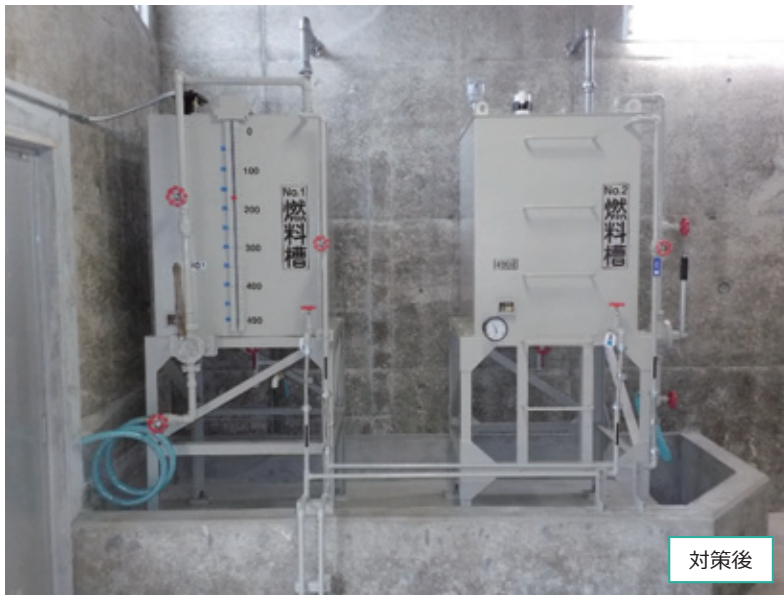
予備発電設備燃料タンク（改良後）
