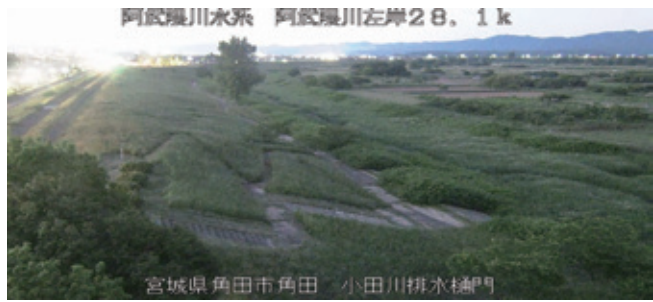
夜間監視対応後のカメラ
