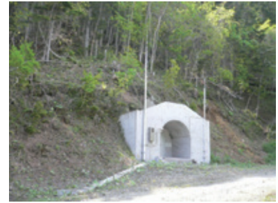
広帯域地震観測網の観測施設
