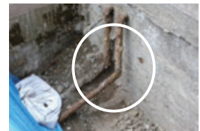
腐食により燃料供給が途絶するリスクのある配管
