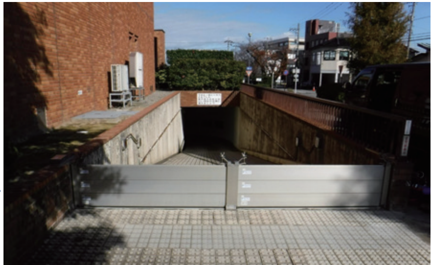
防潮板整備後
