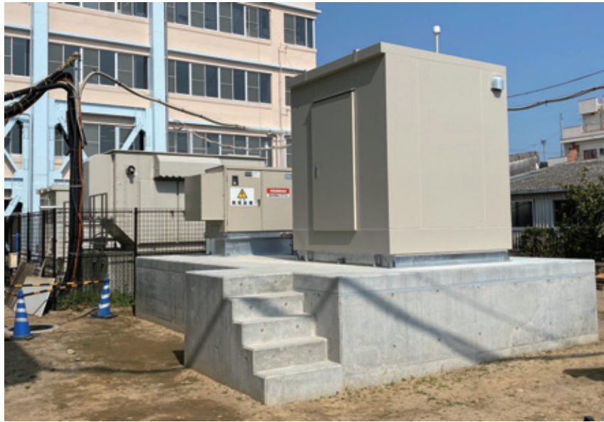
熊本県天草保健所に設置した自家発電設備 (想定される浸水深に対応した高上げや止水対策等も実施)
