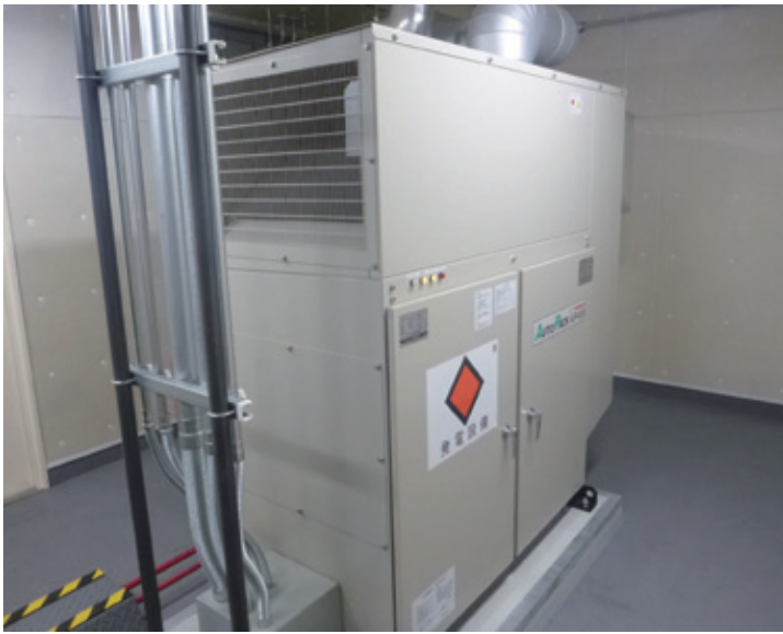
警察通信の維持のために更新した無線中継所の非常用電源設備
