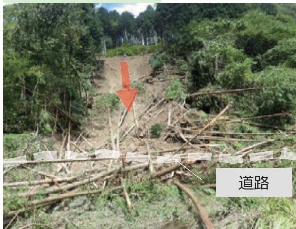
山地の崩壊発生状況
