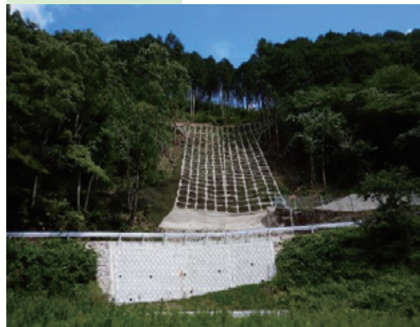
山地の復旧状況
