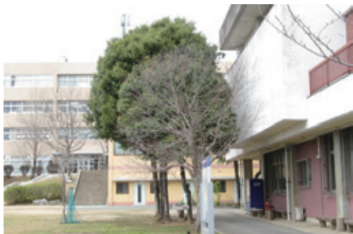
写真：耐震補強工事前
