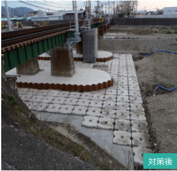
南海本線 男里川橋梁 (橋脚の洗掘対策を実施)
