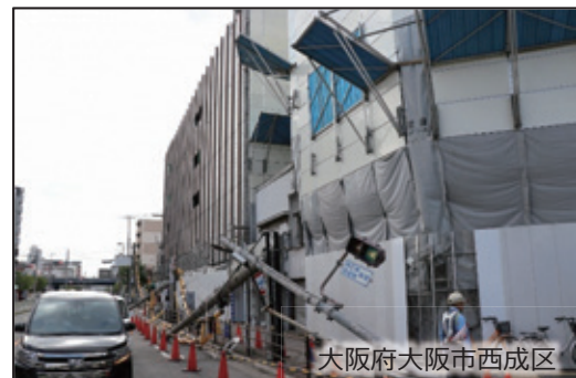
【H30台風21号による電柱倒壊の例】
