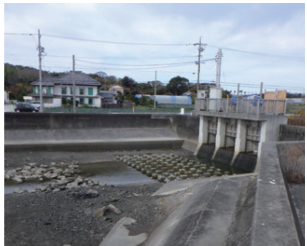
電力供給停止時にも操作が可能となった吉胡樋門
