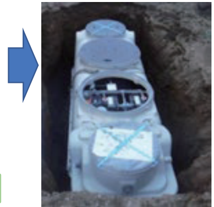
合併処理浄化槽への転換
