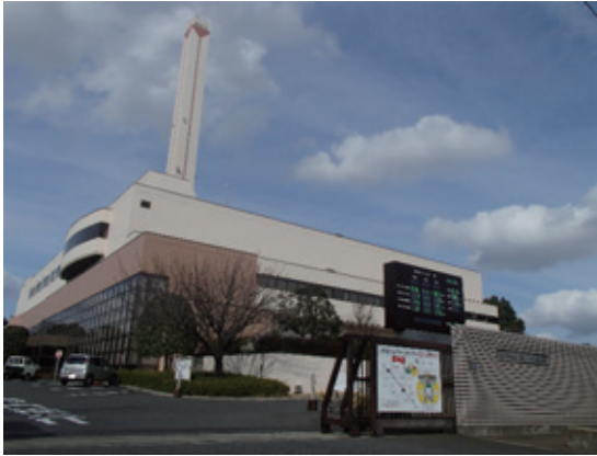
和名ヶ谷クリーンセンター（千葉県松戸市）
