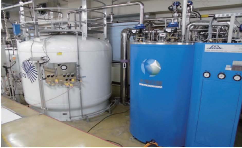
全自動ヘリウム液化システム（北海道大学内外の利用者に対して液化ヘリウムを供給）
