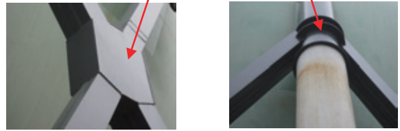
球形貯槽を支える脚部の補強対策
