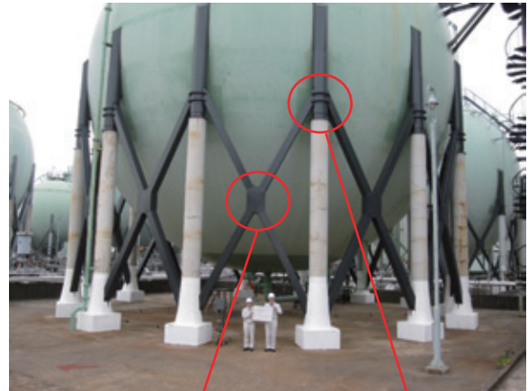
球形貯槽（耐震補強後）
