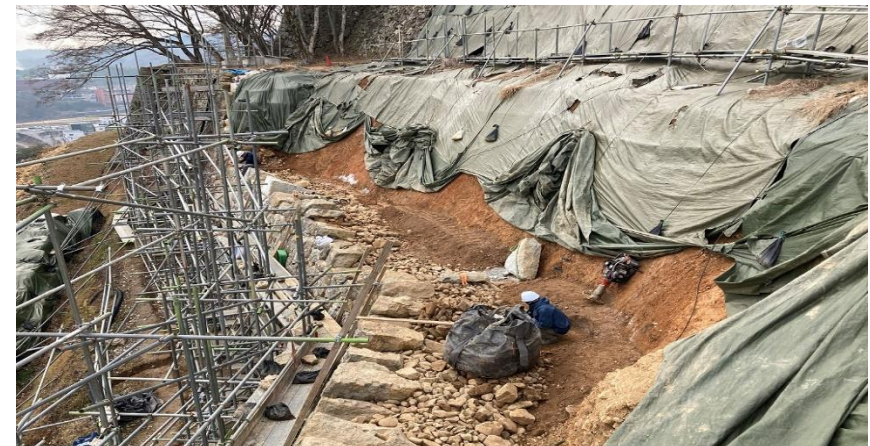
石垣整備：一旦解体し栗石や裏込石を詰め直し作業
